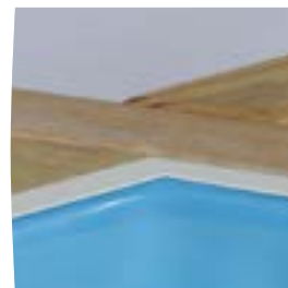
Ziehen Sie den Liner in die Ecken gut fest Tendere bene il liner negli angoli Span de liner strak in de hoeken Estique bem liner nos cantos
